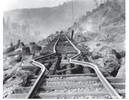
চিত্র ২.১ : উত্তপ্ত আবহাওয়ার কারণে রেল লাইনের আঁকাবাঁকা হয়ে যাওয়া
